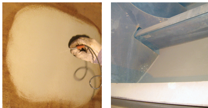
Прекрасное состояние покрытия балластного танка после 15 лет службы. Intershield 300 не разрушается на кромках.
